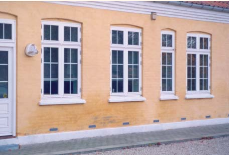
Opstigende grundfugt i facade
